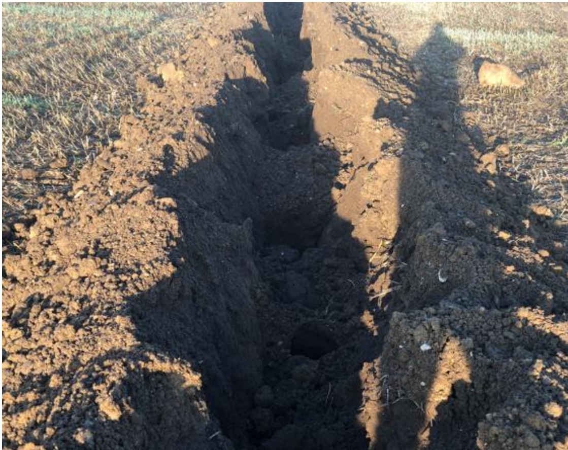
Kedjegrävning med rivtand
