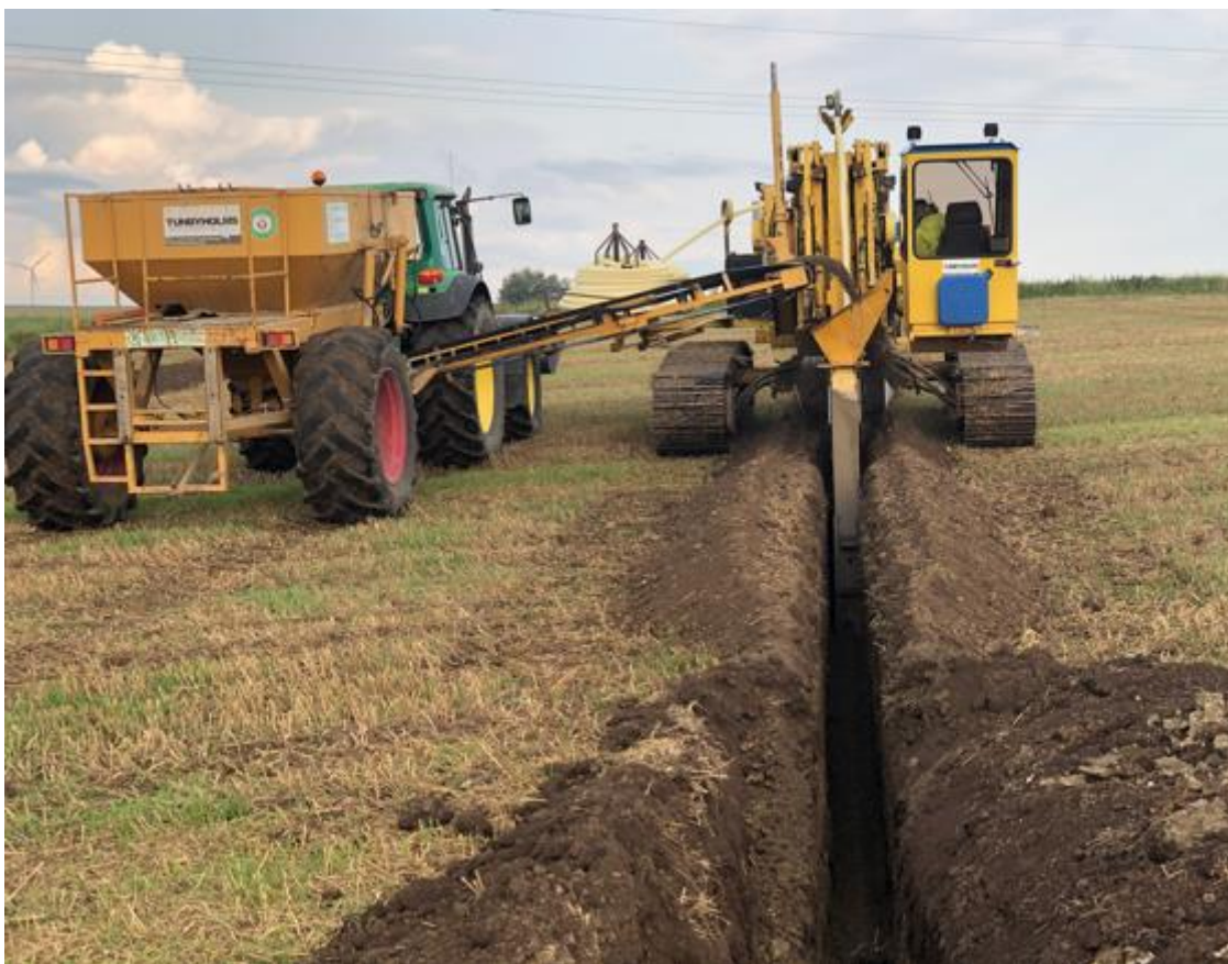
Kedjegrävare och traktor som fyller på dräneringssten, ej rivtand
